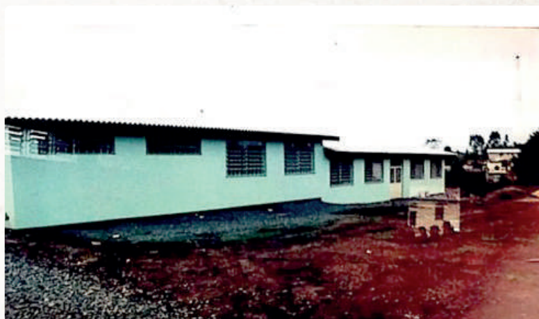
Construção de uma parte da escola. Fonte: Arquivo da Escola Duque de Caxias.
